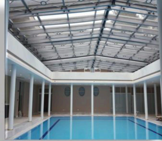
Basbakan Konutu Pembe Köşk Yüzme Havuzu Çelik Konstrüksiyon İşleri Ve Çatının Motorlu Uzaktan Kumandalı Açılır Kapanır Sistem Yapılması
