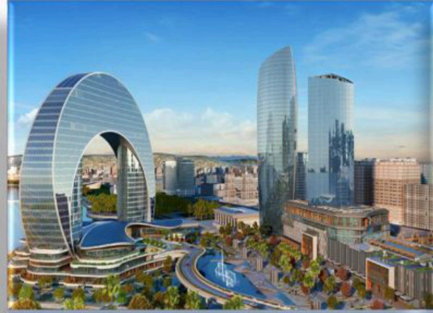
Bme Asansör - Schindler Asansör Azerbaycan Bakü Crescent Development Project Asansör Çelik Taşıyıcıları İmalat Ve Montajı 90 Ton H:196 Mt
