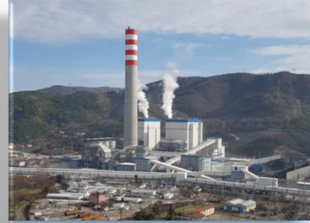
Eren Enerji Holding Zonguldak Termik Santrali Muhtelif Miktarlarda Çelik Konstrüksiyon İşleri Kaplama İşleri - Mekanik İşleri Yapımı Ve Malzeme Tedarigi
