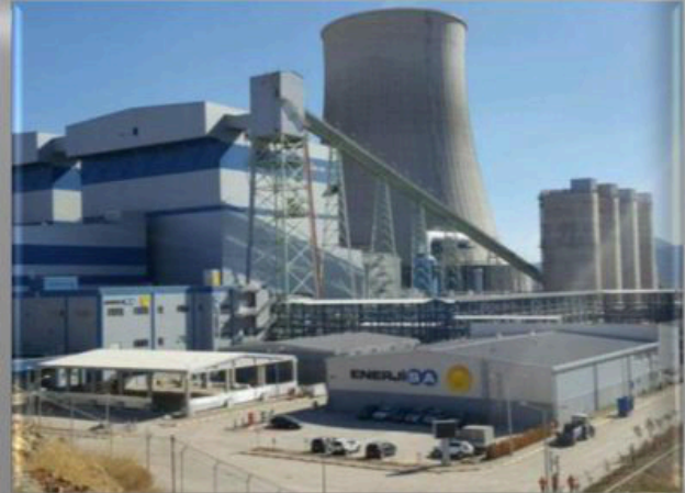
Enerjisa -Elbistan Hes Ve Tufanbeyli Termik Santralleri - Türbin Ve Kazan Binası 17.000 M2 Plyürea İzolasyon -Çelik Konstrüksiyon Yapılar -Kaplama İmalatları -Sifonik Sistem Yağmur Suyu Toplama Hattı Onarım Ve Kısmi Yenileme Mekanik Tadilatlar Ve Onarımlar -Özel İşlenmiş Çelik Malzeme Tedariği.
