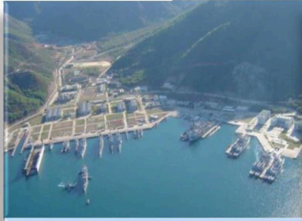
Marmaris – Aksaz Aselsan Kolaylık Tesisleri Hangar Yapıları Anahtar Teslim Proje Taahhütü
