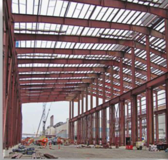
Kolin-Ankara Fabrika Binası - Çelik Konstrüksiyon Çatı Ve Cephe Kaplamaları-Anahtar Teslim Proje
