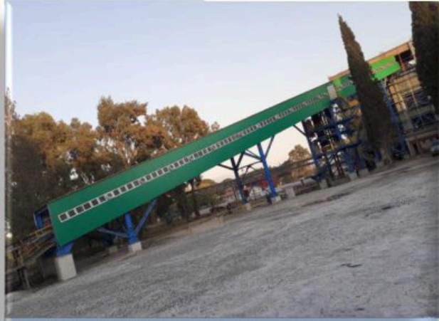
Yatağan Termik Santrali A.Ş. - 31 Galeri Anahtar Teslim Yapılması İşi İhale Bedeli 2.939.380 TL
