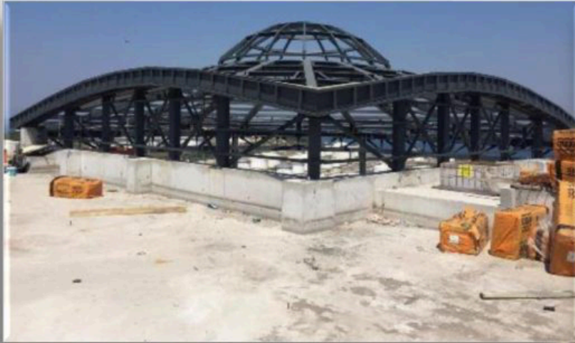
Yenikent Alış Veriş Merkezi - Çelik Konstrüksiyon Ve Kaplama İmalatları
