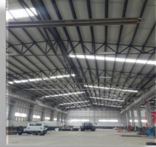
Teknom Metal Fabrikası - Çelik İşleri 200 Ton 5-10-15 Ton Vinç Köprüleri Ve Kaplama İşleri
