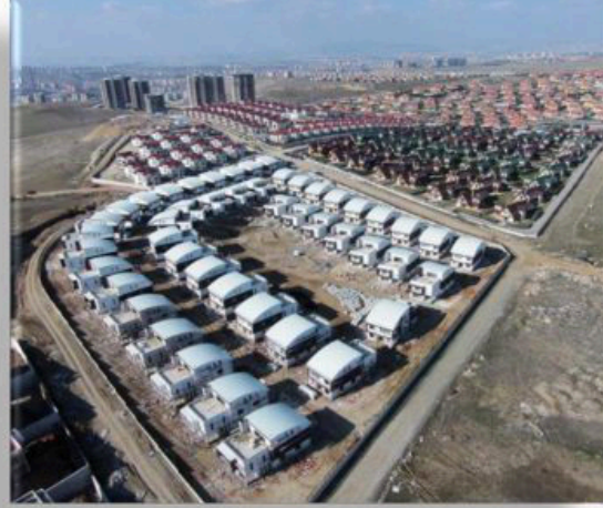
Kardelenköy Villaları (96 Adet) Çelik Tonoz Çatı, İzolasyon Ve Kenet Kaplama İmalatları
