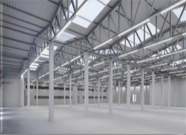
Netelsan - çelik Konstrüksiyon Yapı Karkasının Projeye Uygun İmalatı Ve Kurulumu
