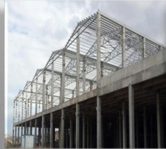
Özgüven Döküm Fabrika Şantiyesi 240 Ton Çelik Konstrüksiyon Çatı Yapımı
